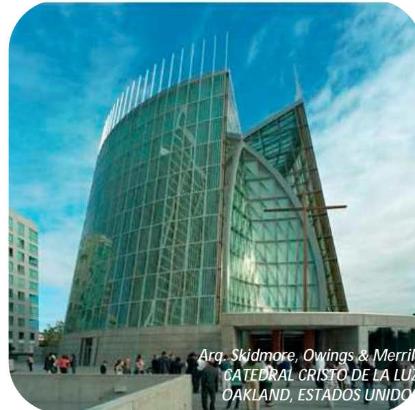
Arq. Skidmore, Owings & Merrill, CATEDRAL CRISTO DE LA LUZ, OAKLAND, ESTADOS UNIDOS.
