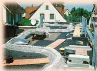
El drenaje colocado en la superficie completa permite un trazado de líneas completamente libre.
