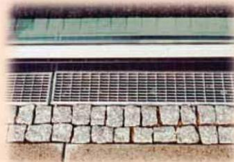
Flexible respecto al diseño, pero de simple realización: las salidas a la cubierta. En este caso es la solución probada con el canal de terraza y de la fachada, conforme a las directivas para cubiertas planas.
