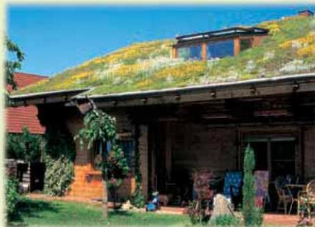
Esta casa particular del dueño de un impermeabilizador en el pueblo de Korb en el valle Remstal en Alemania ha sido tapizada con plantas perennes del sistema "Cubierta ajardinada inclinada" ya en 1987. La cubierta tiene casi 25° de pendiente. Sin riego adicional y cuidando la superficie una o dos veces al año, el carácter de la vegetación apenas ha cambiado. Claro está, a lo largo de los años una u otra planta habrá desaparecido, pero en cambio, el viento o los pájaros trajeron otras.
