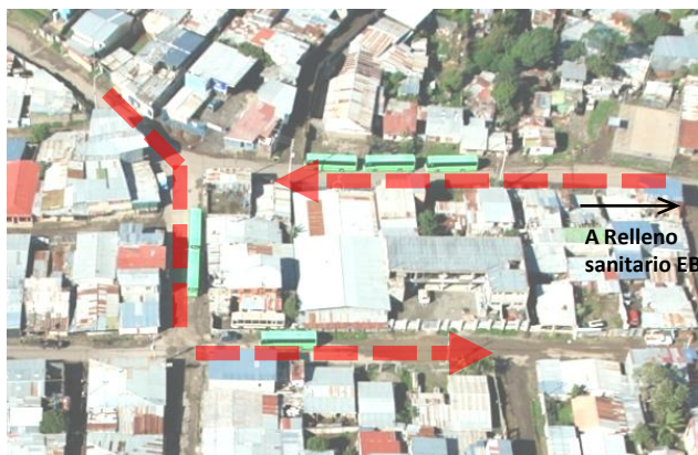
Imagen C.32. Fotografía aérea del sector de la "terminal" actual.
