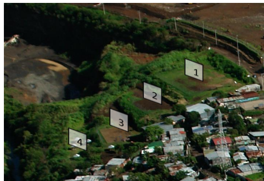
Imagen I.12. Vista aérea del terreno
