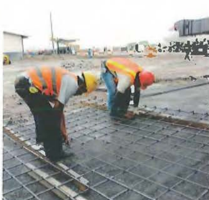
Aquí se construye, actualmente, un nuevo puesto para aviones de cuerpo ancho, al este de la pista. Estará listo a finales de marzo. CARLOS ORENZALEZ
