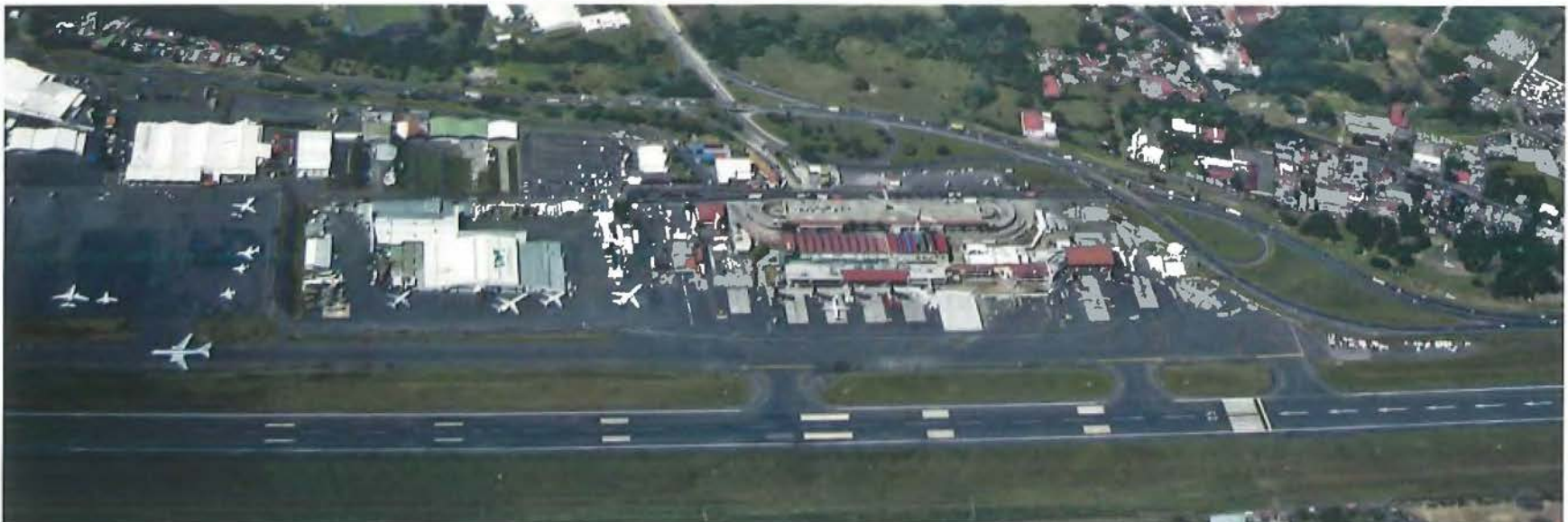
Img 4. Vista aérea del Aeropuerto Internacional Juan Santamaría. 2010.
