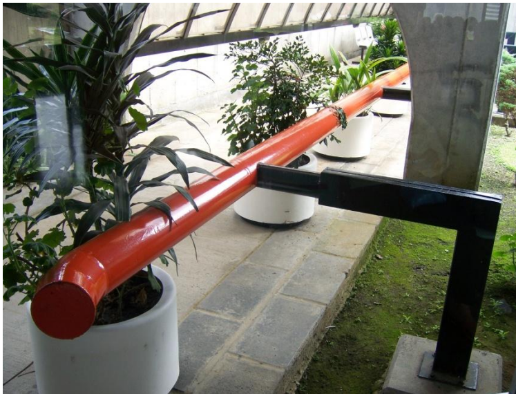
Imagen 32: Detalle pasamanos en pasillos, Clínica de Coronado. Foto: Pablo Meléndez.
