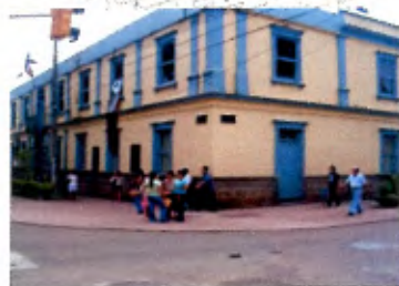
Antigua Gobernación Construcción en bahareque francés y ladrillo de 1910. A partir del 2000 sede regional de la Casa del Artista
