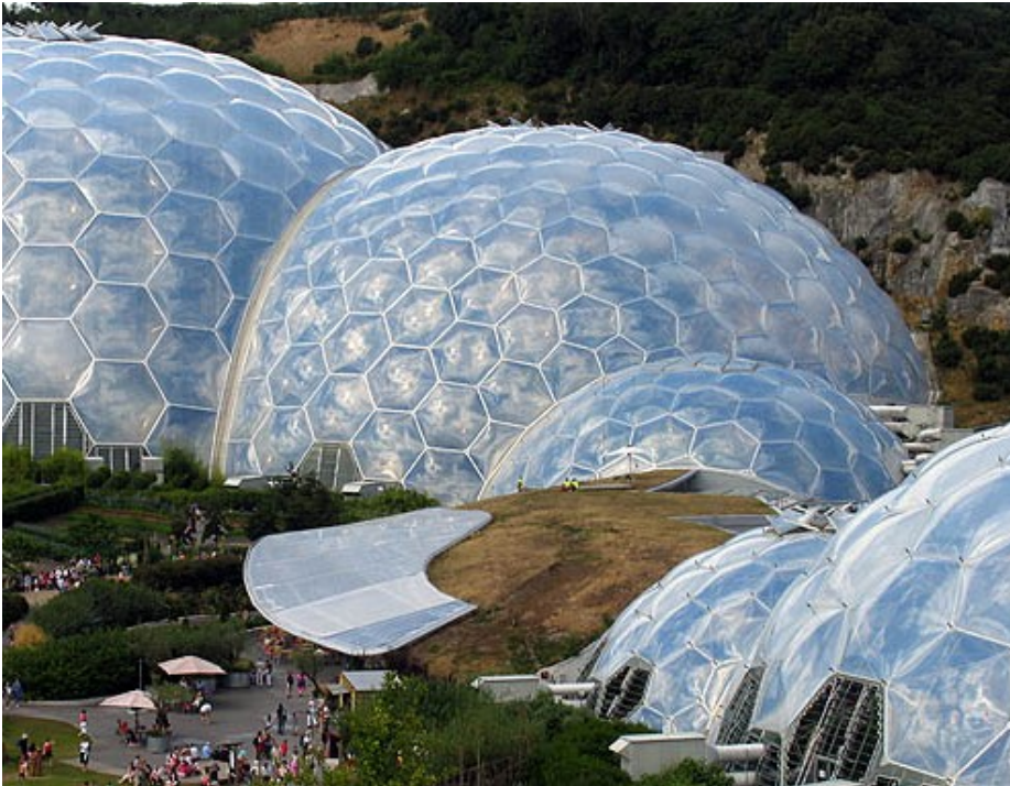
Imagen 76 Vista aérea Eden Project
