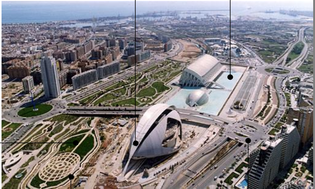
Fig.41. Vista de conjunto CAC
