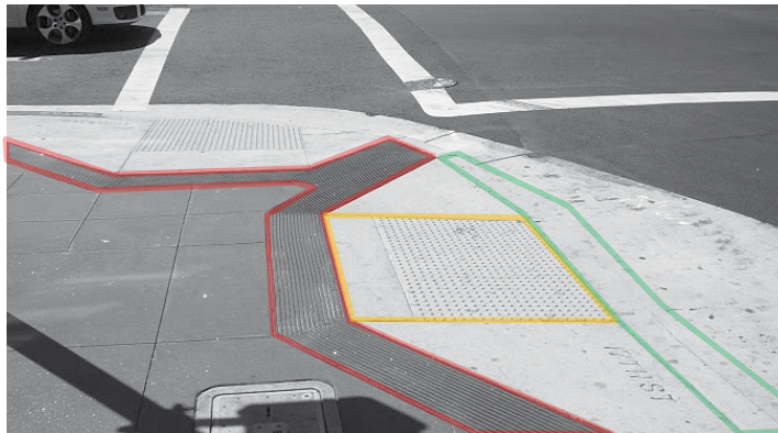
Imagen 51: Rebaje en esquina
