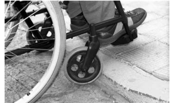
Imagen 49: desnivel no practicable, mal diseño por diferencias entre acera y calzada.
