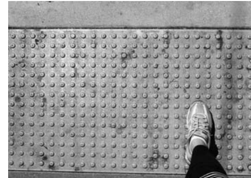
Imagen 54: textura de alerta de 80 cm de profundidad para avisar cambio de nivel e inicio de rampa.
