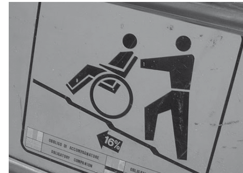
Imagen 55 señalización de rampa con pendiente sobre lo recomendado indicando la necesidad de ayuda de terceros.
