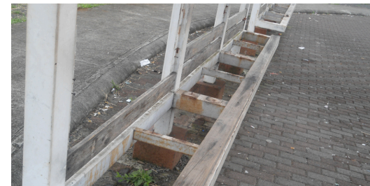
Fig.B.15 foto: detalle parada de bus, parque de la segunda rotonda. Diciembre 2011. Fuente: propia
