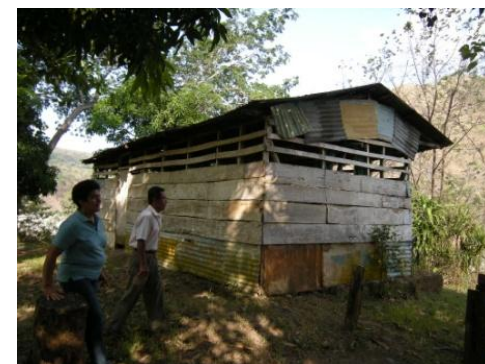
Figura 1.7. Iglesia de Lagarto. Fuente: Propia
