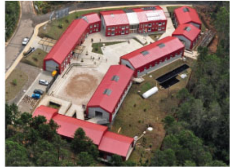
Imagen 51 : Vista aérea Fuerte de Carabineros Fuente : www.plataformaarquitectura.cl
