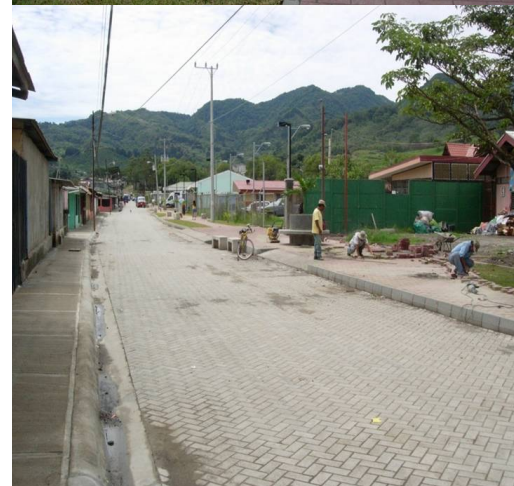
Fig.8 Conjunto de fotografías: mejoras del proyecto de Bono Comunal en Los Guido, Desamparados. Fuente: www.fuprovi.org
