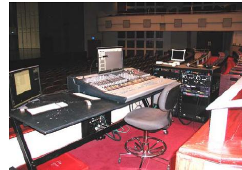
IMAGEN.166: Zona de control de sonido y proyecciones del Centro Lied de Kansas.
