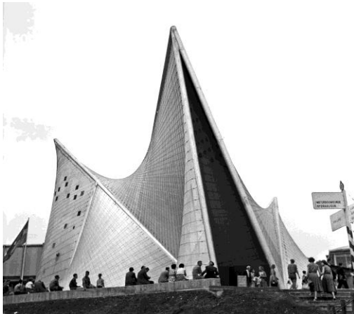
IMAGEN.35: Pabellón Philips de la Exposición Internacional de Bruselas de 1958. Diseñada por el músico y arquitecto Iannis Xenakis. Una obra que manifiesta la unión entre la música y la arquitectura.
