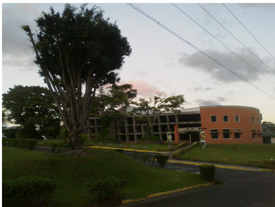
Imagen 6: Edificaciones existentes Fuente: propia
