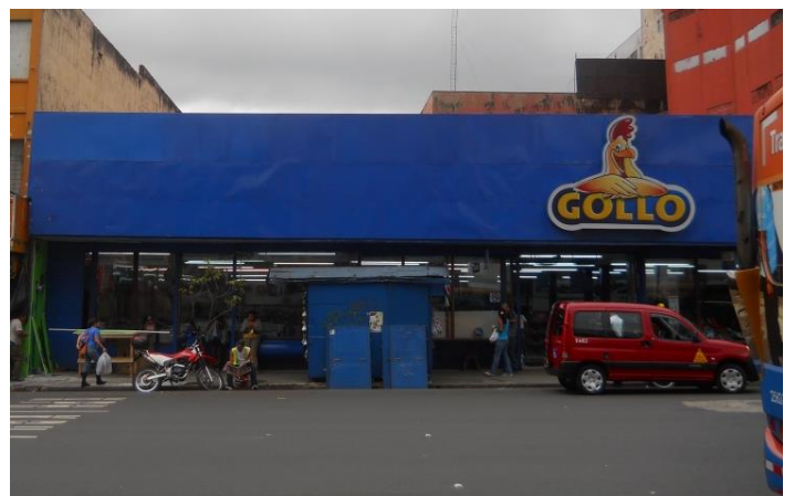
----- Imagen 69. Fuente: fotografía propia del edificio 14, el cual sobresale por su color vivo. Fecha: 16 de febrero del 2013.
