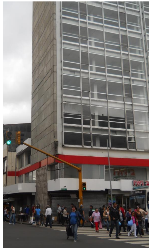
----- Imagen 89. Fuente: Fotografía propia, del edificio con pisos vacíos (70-74) de la Cuadra 12. Fecha 9 de noviembre del 2012.
