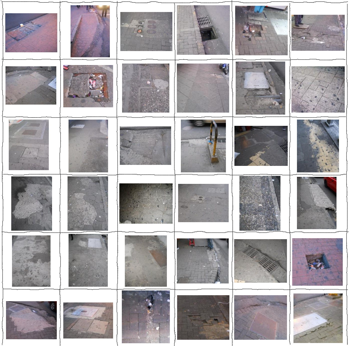
----- Imagen 141. Fuente: Fotografías propias, aceras en la Avenida Segunda. Fecha 16 de febrero del 2013.
