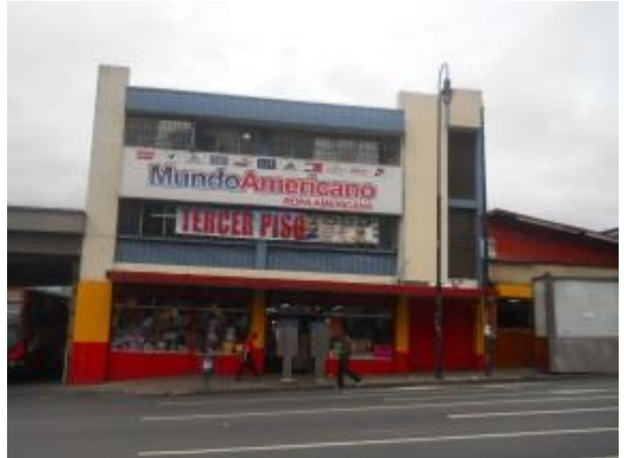
----- Imagen 63. Fuente: Fotografía propia, tienda de ropa americana, no se abstrae del todo de su función, aunque sobresale según los habitantes del paisaje, por tener 3 pisos. Fecha 29 de octubre del 2012.
