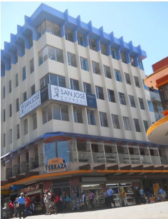
----- Imagen 94. Fuente: Fotografía propia. Edificio Gimnasio San José Fitness y Bar-Restaurante La Terraza (105). Fecha 11 de febrero del 2013.
