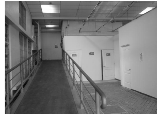
Fig. 9 y 10 Oficinas, Edificio Central
