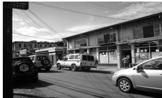
Fig. 8 Odontología, Edificio Central
