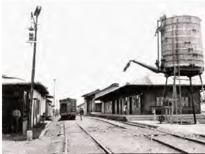
(Imagen 22) Construcción del ferrocarril de Costa Rica
