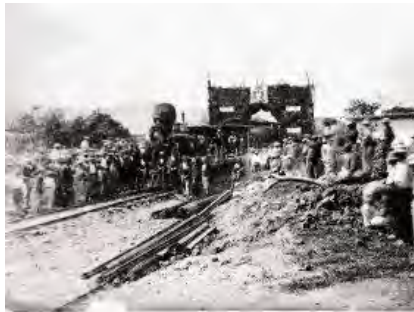
(Imagen 23) Construcción del ferrocarril de Costa Rica
