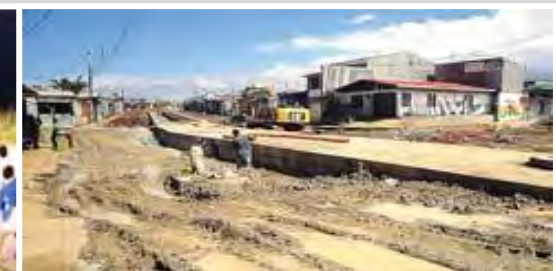
Imagen 09_Primeros trabajos de reparación Fuente: www.aldia.com
