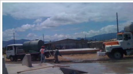
Imagen 25_Construcción del parque infantil Fuente: Municipalidad de Paraíso
