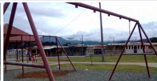
Imagen 26_Juegos Infantiles deteriorados Fuente: Propia
