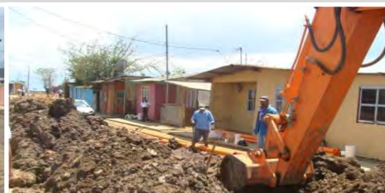
Imagen 11_Excavacion del canal Fuente : Municipalidad de Paraíso
