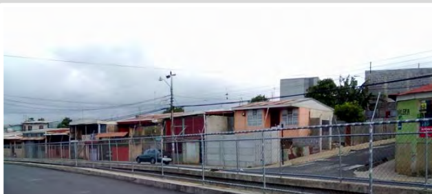
Imagen 19_Viviendas cerca del Canal Pluvial, Llanos de Santa Lucía Fuente : Propia
