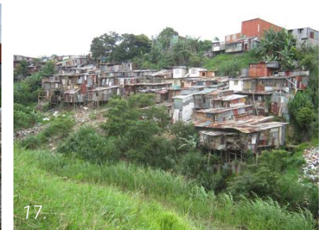
Imagen 17. Quebrada Ribera. Afluente de río Virilla. Asentamiento Informal, Invasión de las Márgenes. Julio 2011. Fotografía tomada por Arq. Douglas Morales
