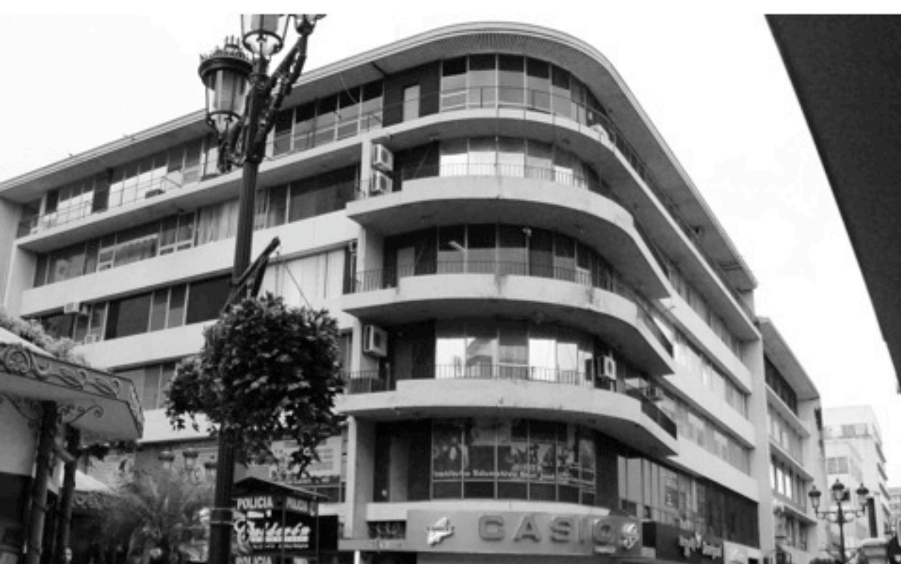
Fig.34: Edificio Schytfer, arq. Paul Eremberg 1954 sobre Banco Central/ Fuente: autor
