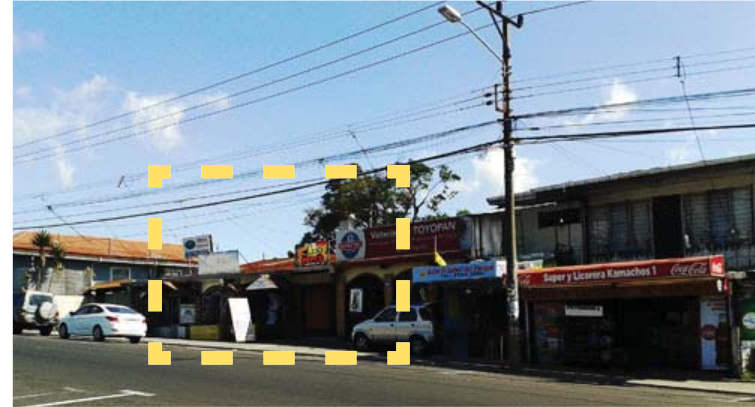
Fachadas del Centro de Coronado, carecen de Invitación y Permeabilidad
