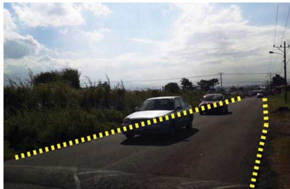
Falta de aceras y pasos peatonales
