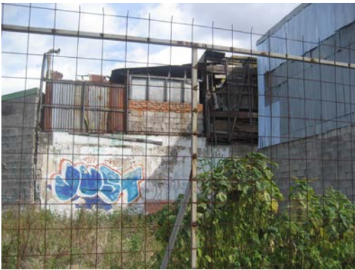
Figura 1. Bermúdez, P. (2014). Deterioro de edificaciones, espacio e imagen urbana en el distrito Catedral.
