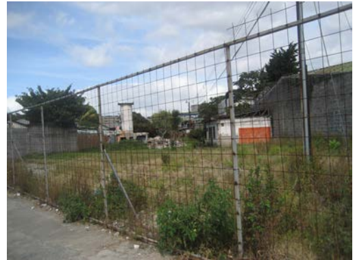
Figura 2. (2014) Demolición, deterioro y espacios residuales en el distrito Catedral.
