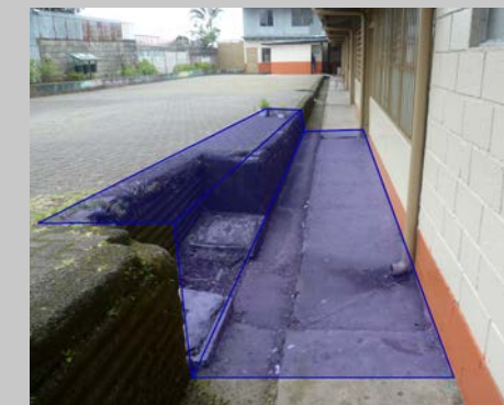
IMAGEN 1.11 (Salidas posteriores de aulas sector sur)
