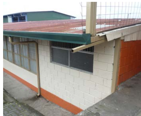
IMAGEN 1.23 (Techo de las instalaciones)
