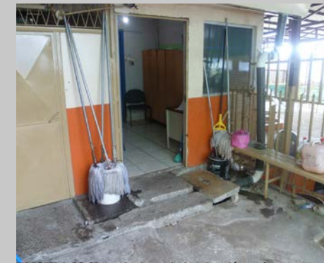
IMAGEN 1.29 (Espacio de trabajo misceláneas)
