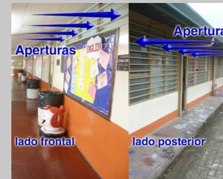
IMAGEN 1.19 (Ventilación cruzada en aulas)
