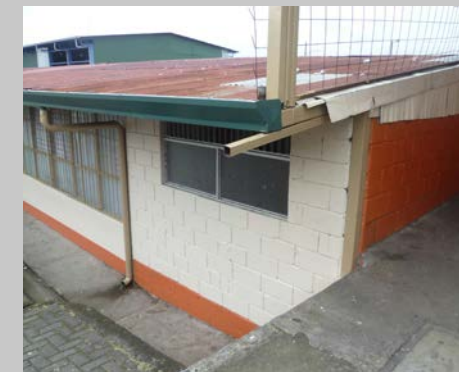
IMAGEN 1.23 (Techo de las instalaciones)
