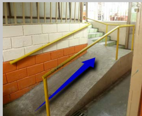
IMAGEN 1.8 (Rampa a sector este)
