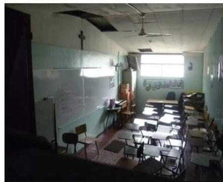
IMAGEN 1.24 (Deterioro de cielo falso)
