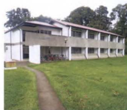
33. Edificio de Alojamiento existente del CATIE.
