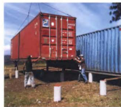
63. Montaje en sitio de un contenedor sobre pilotes
