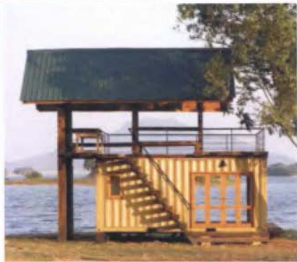
65. Cabaña con base en un contenedor de 10”.
