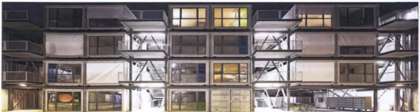
91. Foto frontal hacia el jardín interno de las unidades habitacionales y las pasarelas externas.
