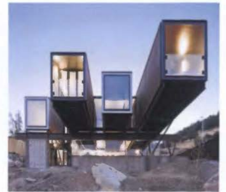
39. La construcción reutilizando contenedores no es algo nuevo.
