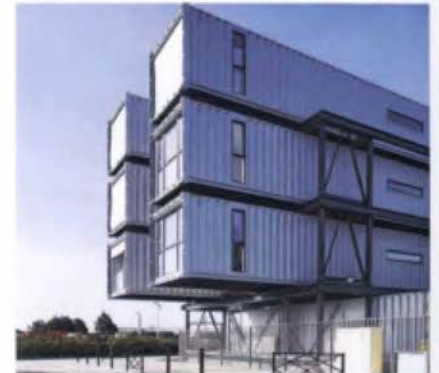
90. Foto lateral de las unidades y su estructura tipo industrial.
