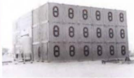
59. Primer edificio de contenedores: almacén portátil diseñado por Steadman Containers, para la carga de cemento en el Ártico.
