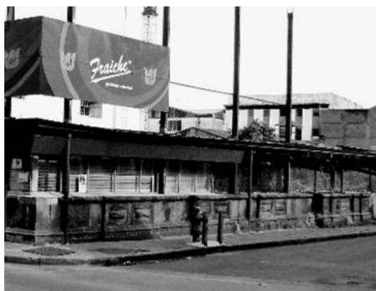
Muro del edificio parqueo de la antigua Biblioteca Nacional. | Fuente: JESSICA ARRIETA PARA LN 2012
