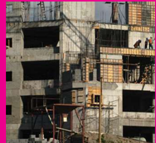
7F 1990's Construcción del edificio de Ingeniería
