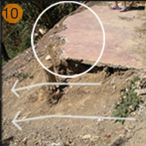
Vestigio de vivienda que fue abandonada debido a desprendimientos de tierra por las grandes pendientes del terreno
