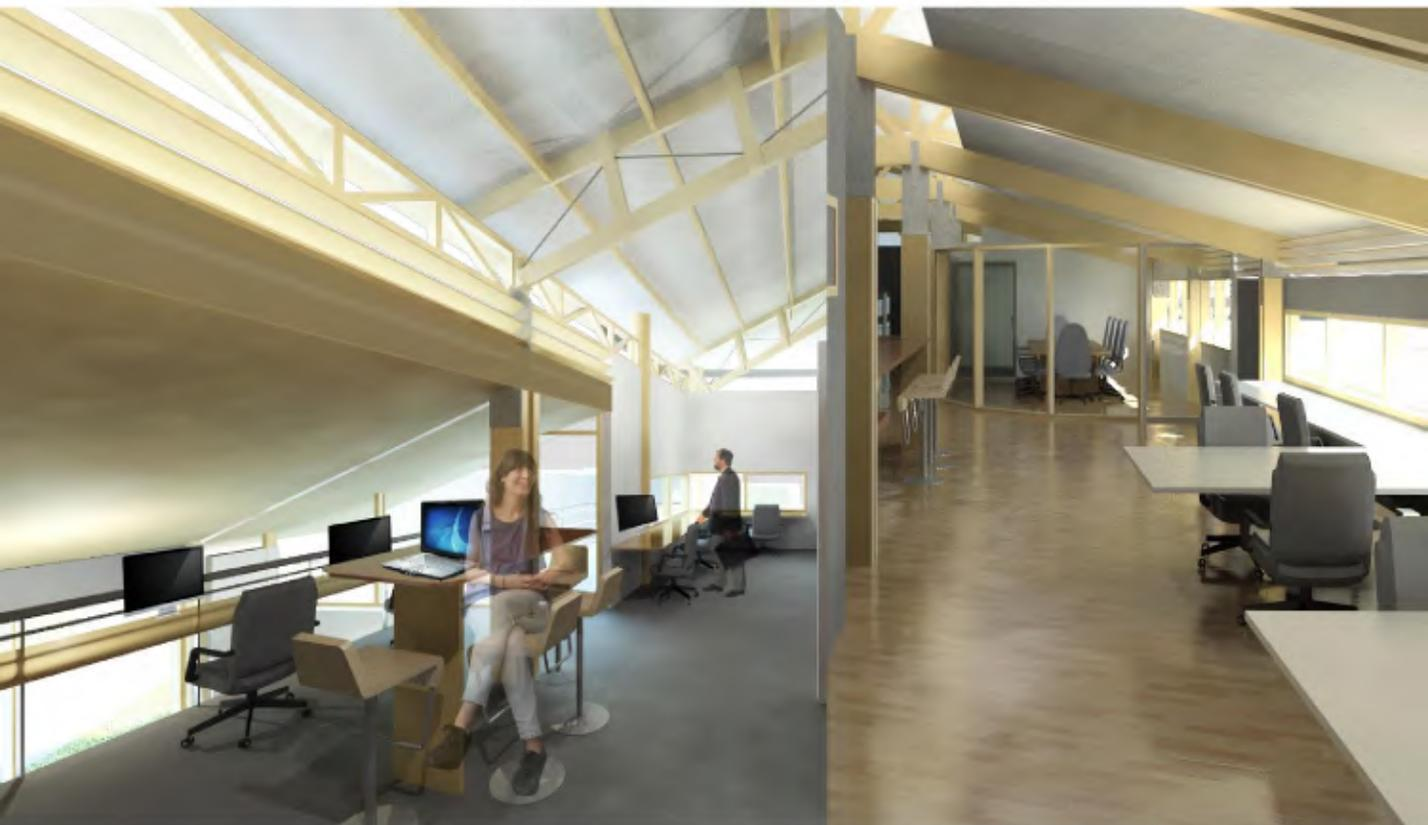
El área administrativa hace un despliegue de la estética de la madera, puesto que le permite exponerse al 100% y aprovechar de la exposición de los detalles constructivos y uniones, los cuales se evitan en las aulas, con el fin de disminuir los elementos visuales. Las columnas de 6m de altura máximo, cierran en placas metálicas de acople que varían en dimensión, según el alcance que deban darle al techo.
