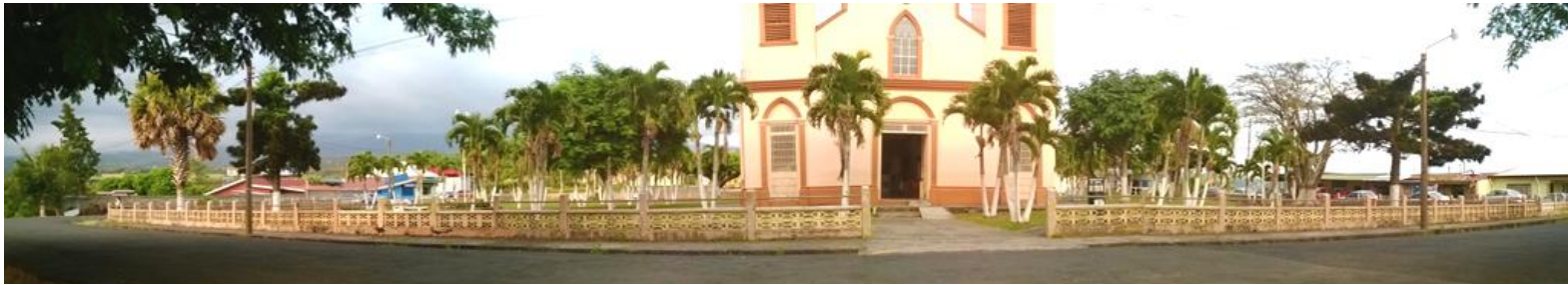
Imagen 22: Fachada Oeste, templo Sta. Gertrudis. fuente propia 02/2014
