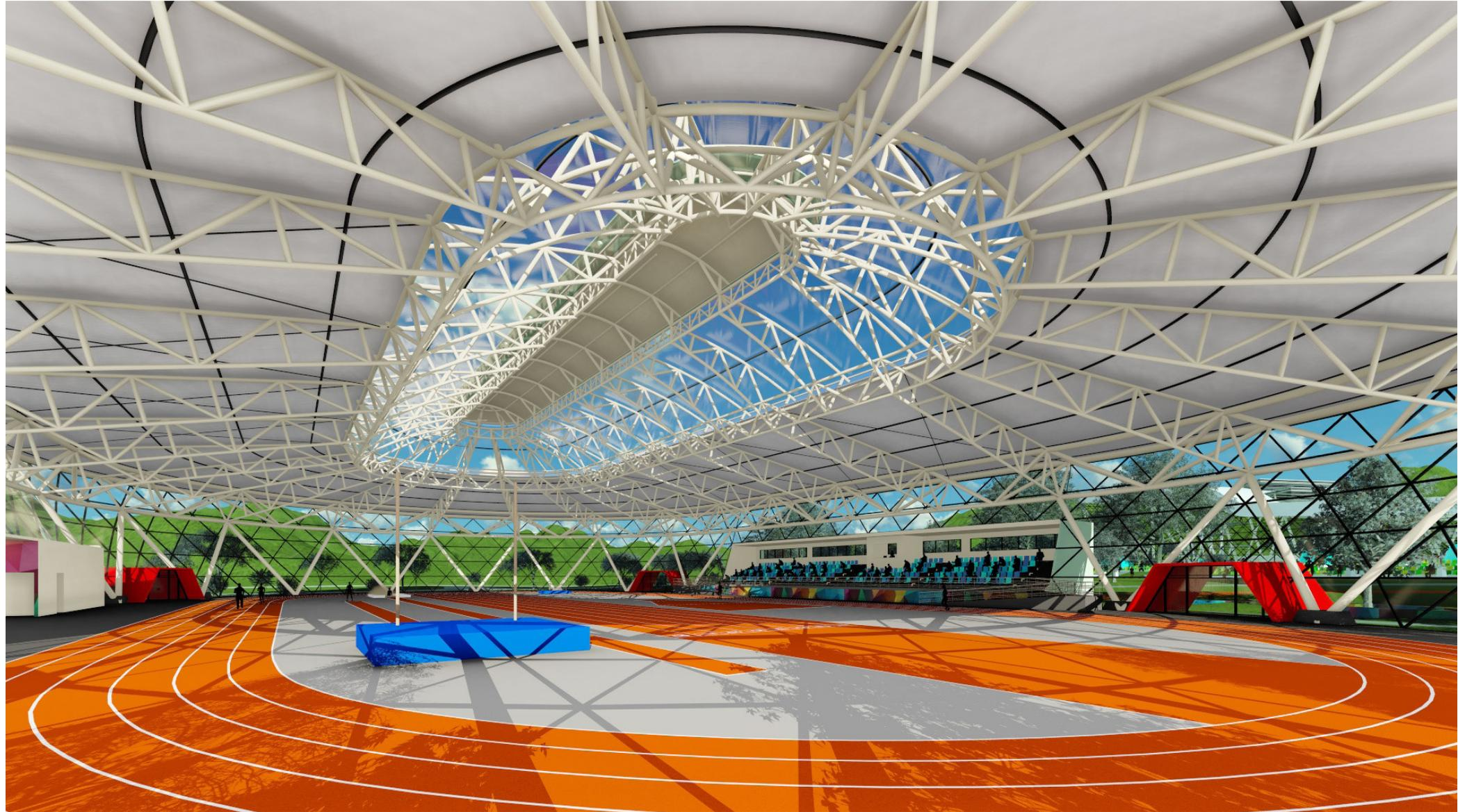
Se observa la estructura en acero expuesta del pabellón, la estructura funciona como un todo. Debido al requerimiento de cubrir extensas luces, la cubierta se soluciona por medio del uso de un anillo de compresión central.
