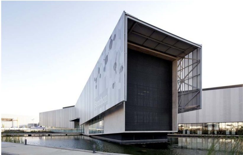
Imagen 46: detalle de la doble piel metálica, obtenido de http://www.plataformaarquitectura.cl/?p=351739
