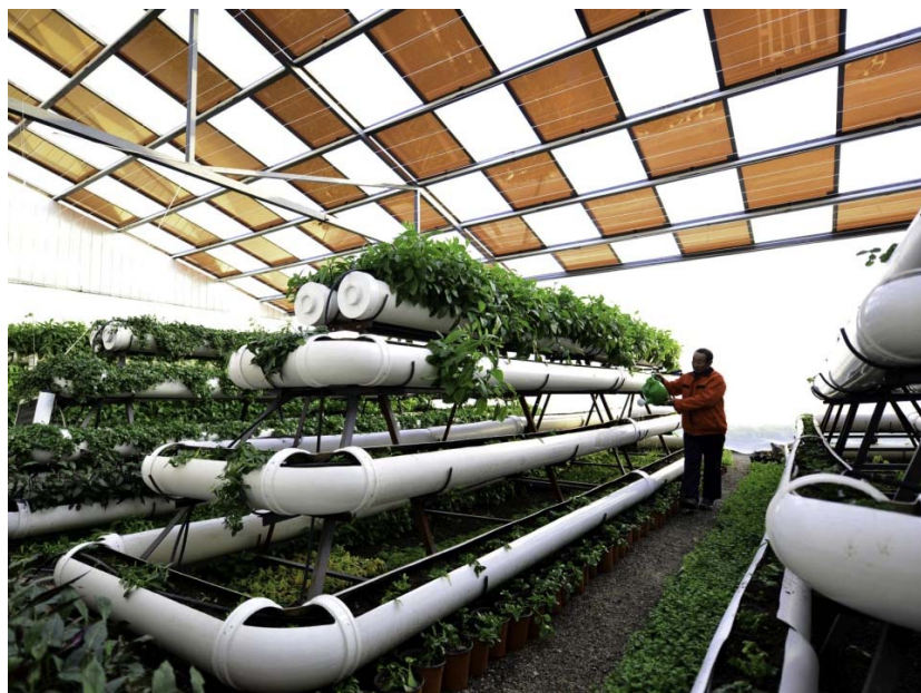
Imagen 32: paneles solares sobre invernadero en Ezhou, provincia de Hubei, china, obtenido de: http://www.agrisources.com.cn/contents/4527/447952.html
