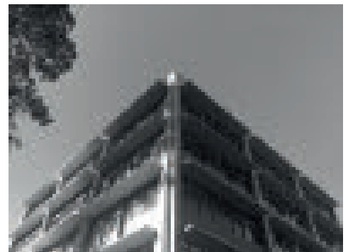
Imagen G44. Parasoles en el anexo de la torre. Fotografía del autor.
