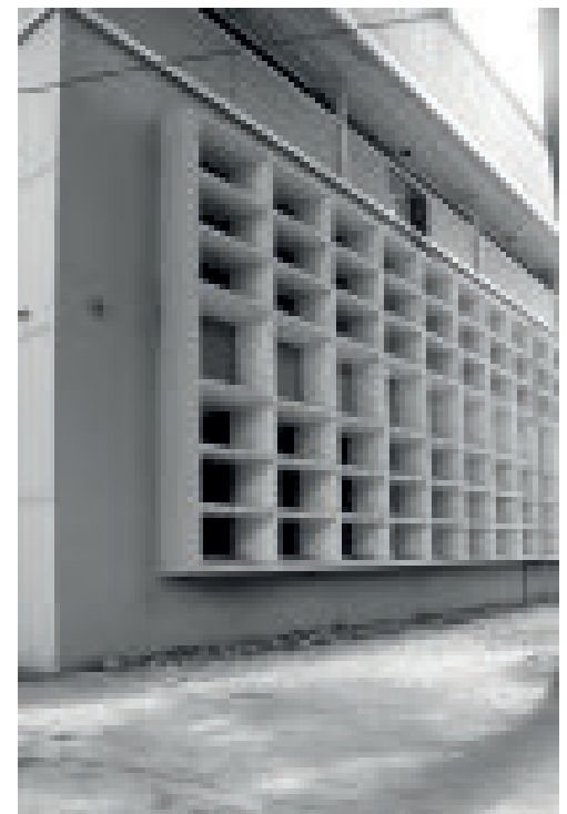
Imagen G75: 2017, Parasoles en retícula del edificio histórico en su estado actual, que están pintados en color amarillo. Pero al pasar la fotografía a escala de grises se puede evidenciar el juego de tonos propuesto entre negro, blanco y gris. Fotografía del autor.
