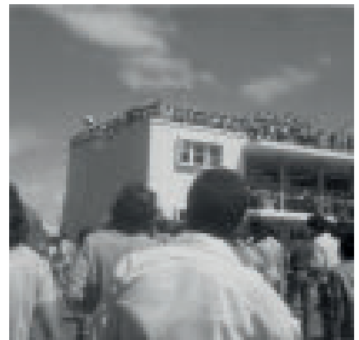
Imagen G11. 1975, Pasada de Derecho en el Edificio de Ingeniería.
