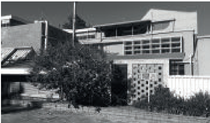
Imagen G106. Instalaciones y bodegas exteriores (fachada este). Fotografía del autor.
