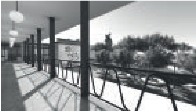
Imagen G81: Vista desde los pasillos abiertos de segundo nivel hacia el núcleo de sanitarios y la explanada. (fachada este) Elaboración propia.
