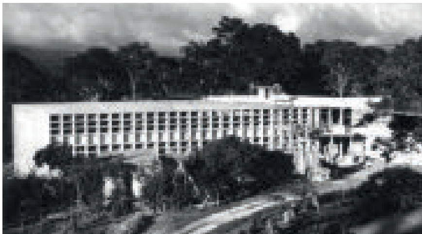
Imagen G46 1953-54 circa, Edificio de la Facultad de Ingeniería en Construcción. Se pueden observar las piezas de madera utilizadas para el encofrado.
