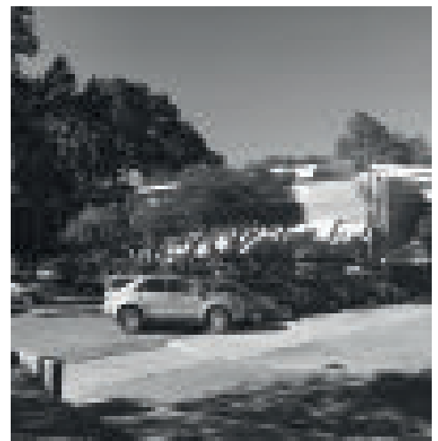
Imagen G45. Incidencia y sombra sobre la fachada este. Fotografía del autor.
