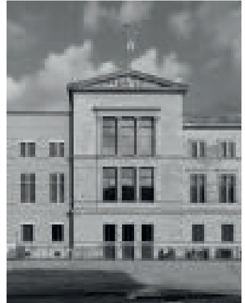
Imagen E20 (Página anterior): Sin fecha, Fachada del Neues Museum, donde se puede observar la diferenciación de la parte original de la reconstrucción.
