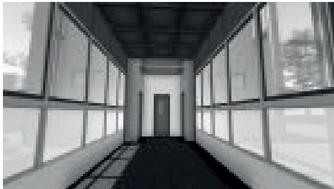
Imagen G83: Vista del conector entre el edificio histórico y el núcleo de sanitarios (1er nivel). Elaboración propia.
