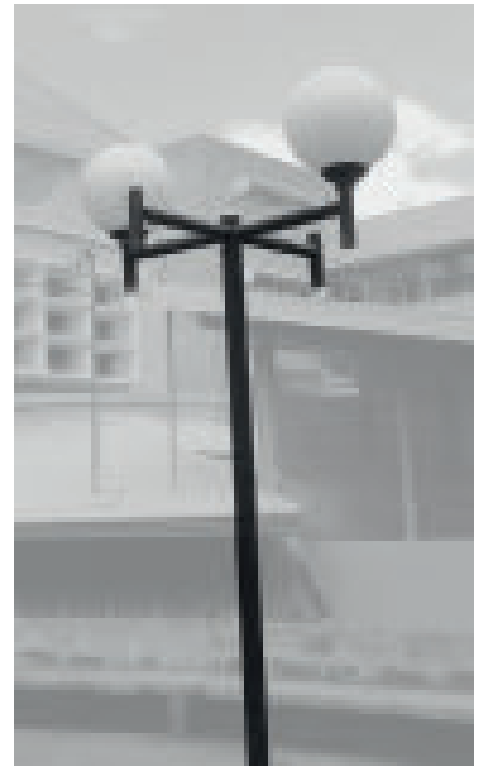
Imagen G104. Antiguas luminarias del campus, actualmente en sustitución. Fotografía del autor.
