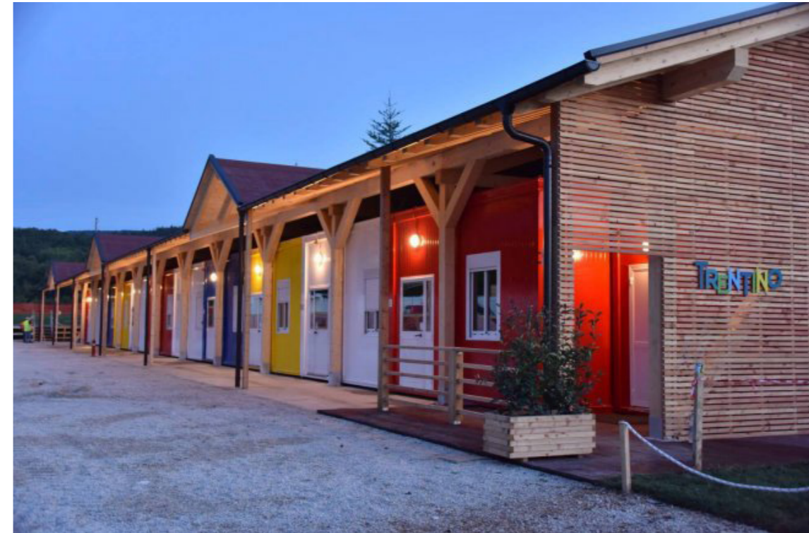
Imagen N° 40. Escuela modular de Amatrice terminada. (L'Adige, 2016)
