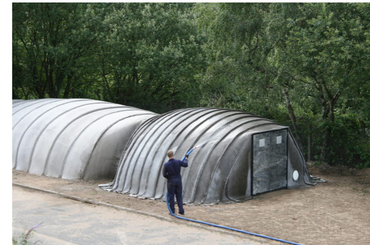
Imagen N° 57. Paso 2. Hidratando la lona Concrete Canvas. Al hidratar la lona se obtiene un espacio habitable al secarse por 24 horas. Fuente: Concrete Canvas, 2017d
