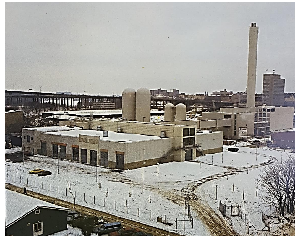
Imagen 42: la planta de calefacción hambyverket, Estocolmo, Suecia Tomado de: Biblioteca Atrium de la arquitectura actual, pagina 112 tomo V
