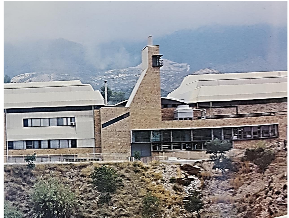
Imagen 44: Planta de cogeneración de la fabrica Jover. Alicante, España. Tomado de: revista Arquitectura Viva Numero 61 Julio-Agosto 1998
