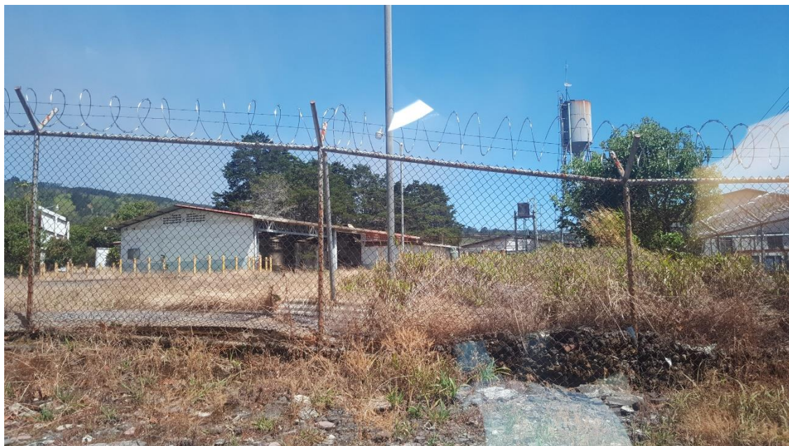
Imagen 5: Fachada Nor-Oeste Praxair
