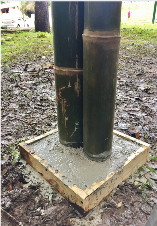
Img. 28 | Chorrea de columna doble de bambú guadua. 12cms de diámetro @, 3m de largo. La base de concreto usualmente es más alta (40-70cms del suelo) para evitar el contacto del bambú con el agua.
