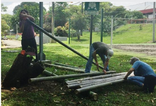
Img. 22 | Luego se trabajó en el montaje de las columnas, que de acuerdo al diseño serían dobles. Las uniones se hicieron con tornillos y arandelas.<sup>32</sup>
