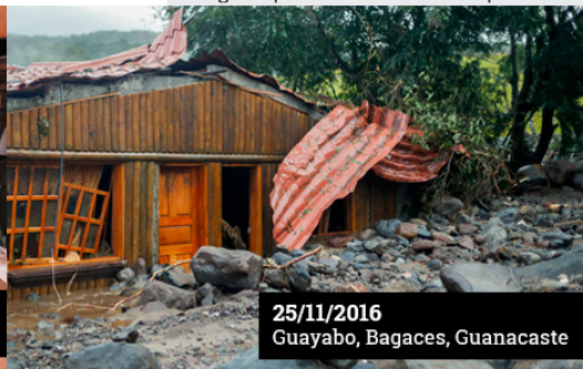
Img. 04 | Viviendas afectadas por Otto. 10
