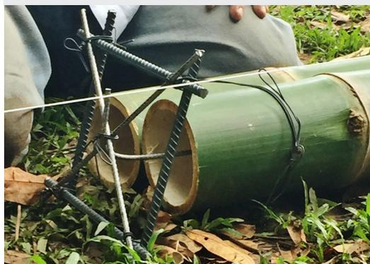
Img. 24 | Puesta de la columna antes de la chorrea. El bambú, al contrario que la madera, puede tener contacto directo con el concreto sin que este le cause daños al material.<sup>32</sup>
