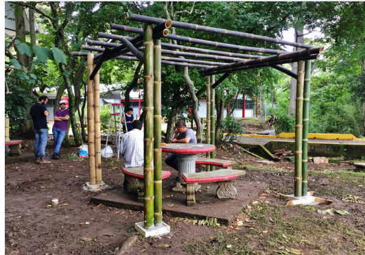
Img. 29 | Pérgola terminada. Dimensiones: 3x3x3m.
