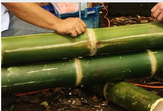
Img. 23 | Después de las columnas debidamente armadas, una de las cañas fue atravesada con una varilla la cual estaba conectada con la base y la viga en la parte superior.<sup>32</sup>
