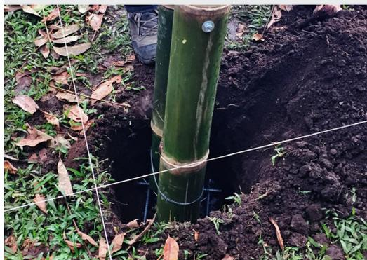
Img. 25 | Colocación de columnas y vigas. En este caso por ser solo una muestra se trabajó el bambú guadua en estado verde para las columnas y el bambú negro para las vigas.<sup>32</sup>
