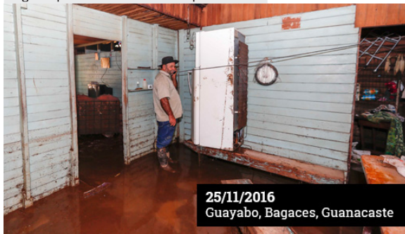
Img. 03 | Viviendas afectadas por Otto. 10
