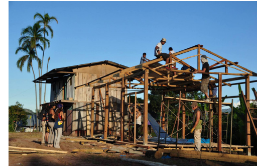
Imagen 4. Construcción del Centro Comunal de la CCNN por parte de la comunidad en Alto Sondoveni Satipo en Perú.
