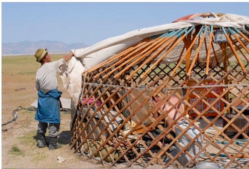
Imagen 6. Instalación de Yurta en estepa mongola.
