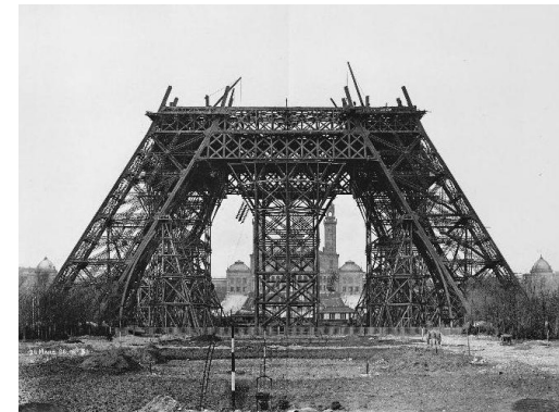
Imagen 16. Montaje de vigas horizontales de la Torre Eiffel (20 mayo 1888).
