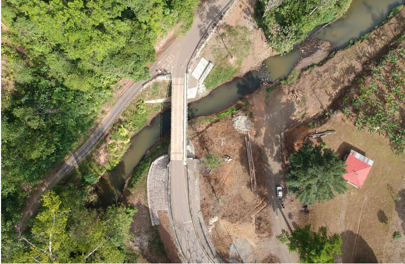
Imagen 22. Vista aérea sobre el nuevo puente del río Riyito. Fuente: PIOSA - UCR (2018)
