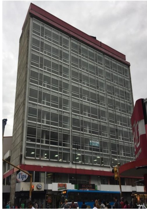
26 EDIFICIO ANT. MUN. SJ
