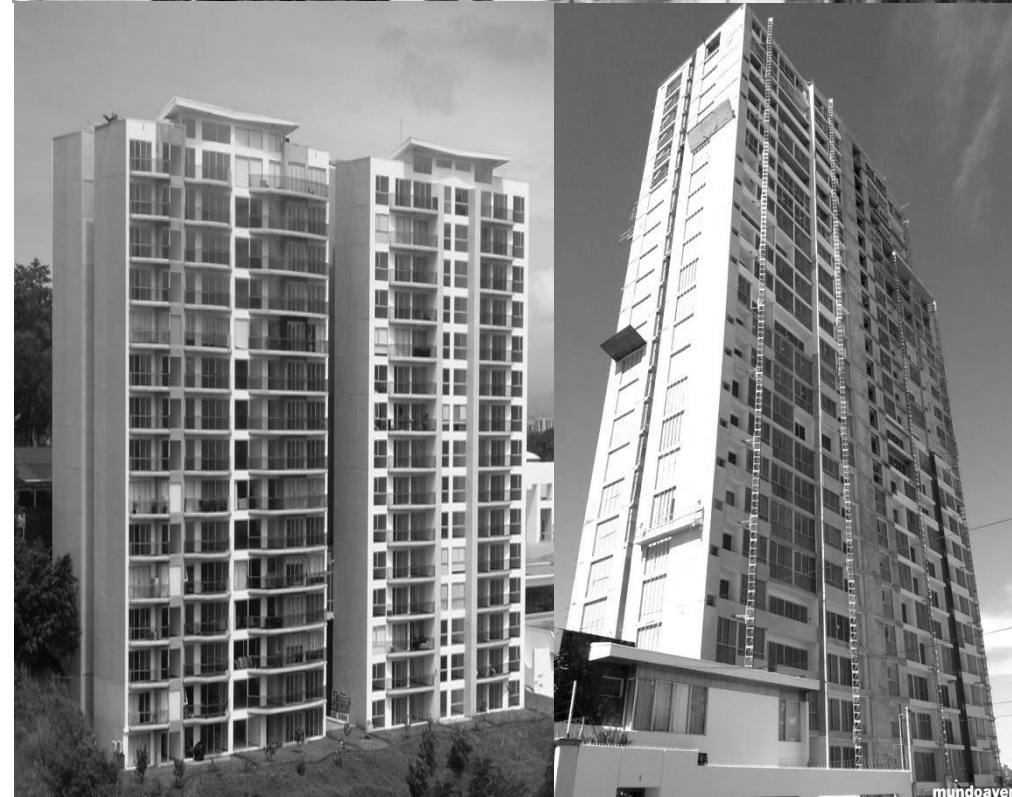
IMAGEN 14: EDIFICIO TORRES PASEO COLÓN FUENTE: SKYSCRAPERCITY
