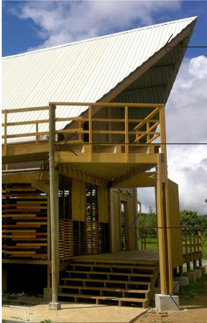
● Manejo de cubiertas con una inclinación pronunciada para combatir la cantidad de lluvia y se genera como cerramiento del segundo nivel.
