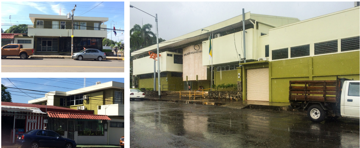
Figura 77. Palacio Municipal de Orotina (PMO). Fotografías tomadas por autores.
