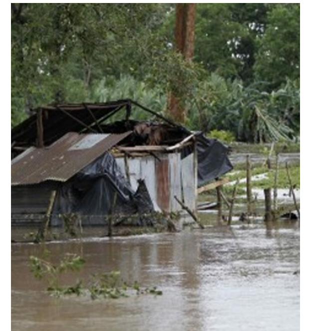
IMAGEN 4 (derecha): Una casa destruida tras el terremoto de Cinchona (2009) en Alajuela, Costa Rica. Fuente: Southcom photo gallery. 2009.
