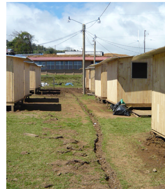
IMAGEN 2 y 3 (izquierda superior e inferior): Fotografías de campamento transitorio de emergencia compuesto por viviendas temporales de la ONG “Un Techo Para Mi País”. Ubicado en la Plaza de Poasito, Alajuela. Fuente: MIVAH. 2009
