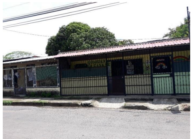
Imagen 9/93: Fotografía del contexto del lote seleccionado. Fuente: Rodríguez Acosta, C. (2020).
