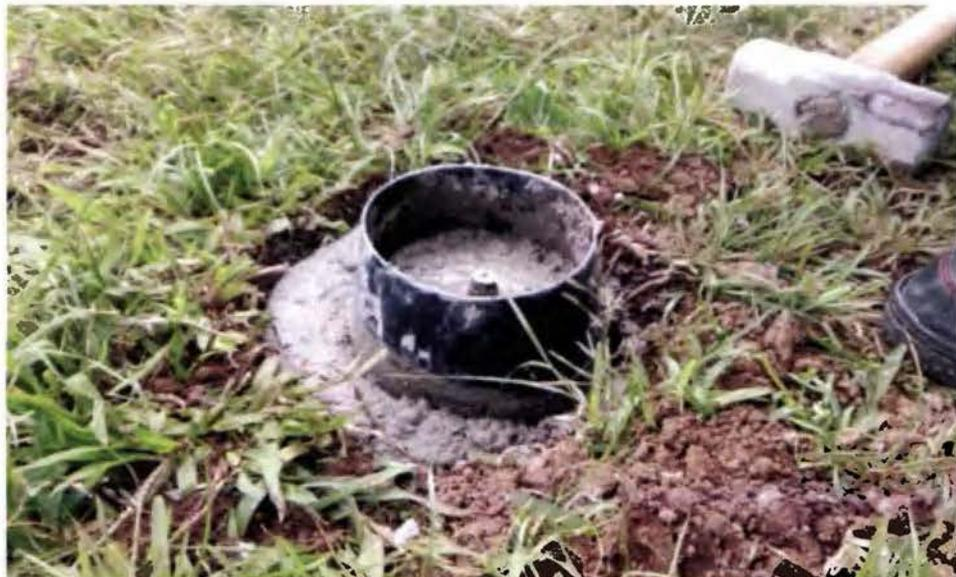
Figura N°21: Molde para los Hitos
