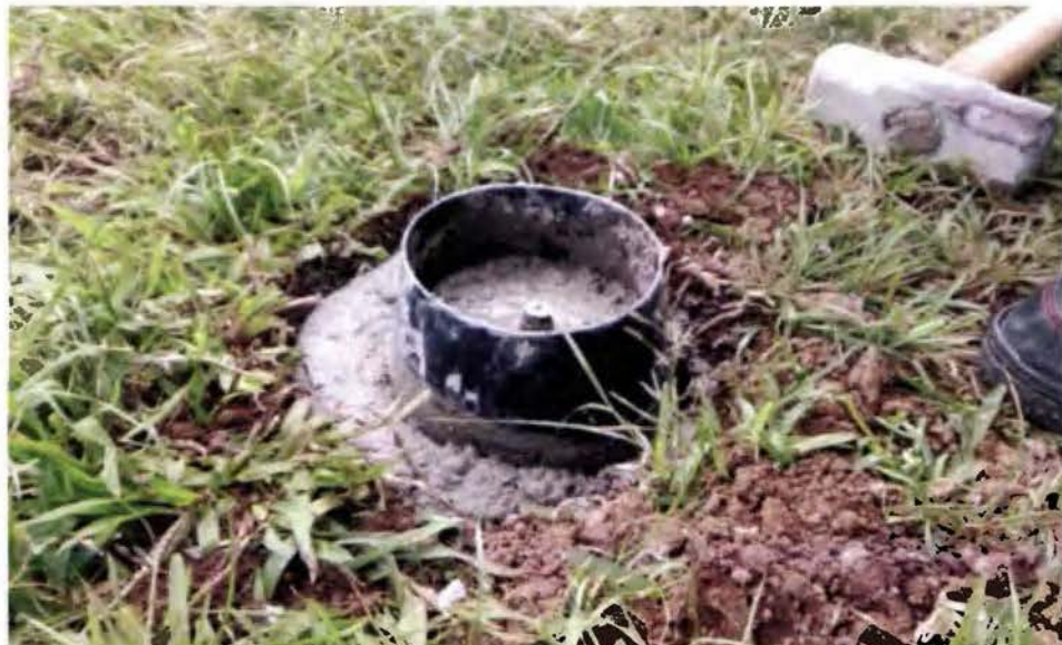
Figura N°21: Molde para los Hitos Fuente: Propia
