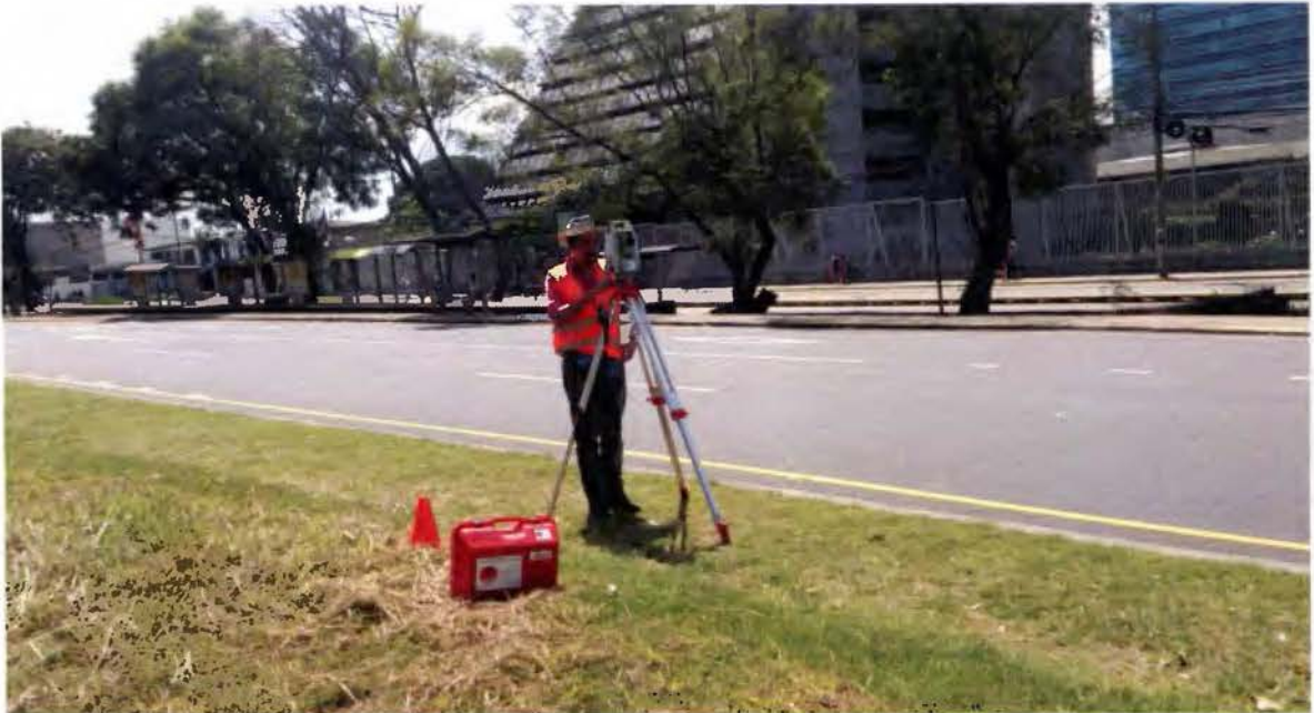
Figura N°45: Medición de distancias horizontales de la Base Fuente: Propia
