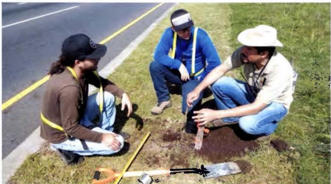
Figura N°18: Excavando para crear Hito N°1 Fuente: Propia
