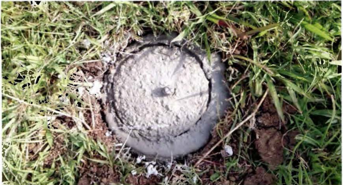
Figura N°25: Hito finalizado Fuente: Propia
