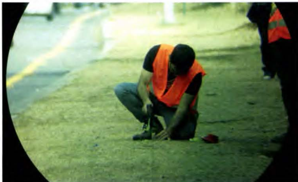
Figura N°15: Colocando taco preliminar Fuente: Propia
