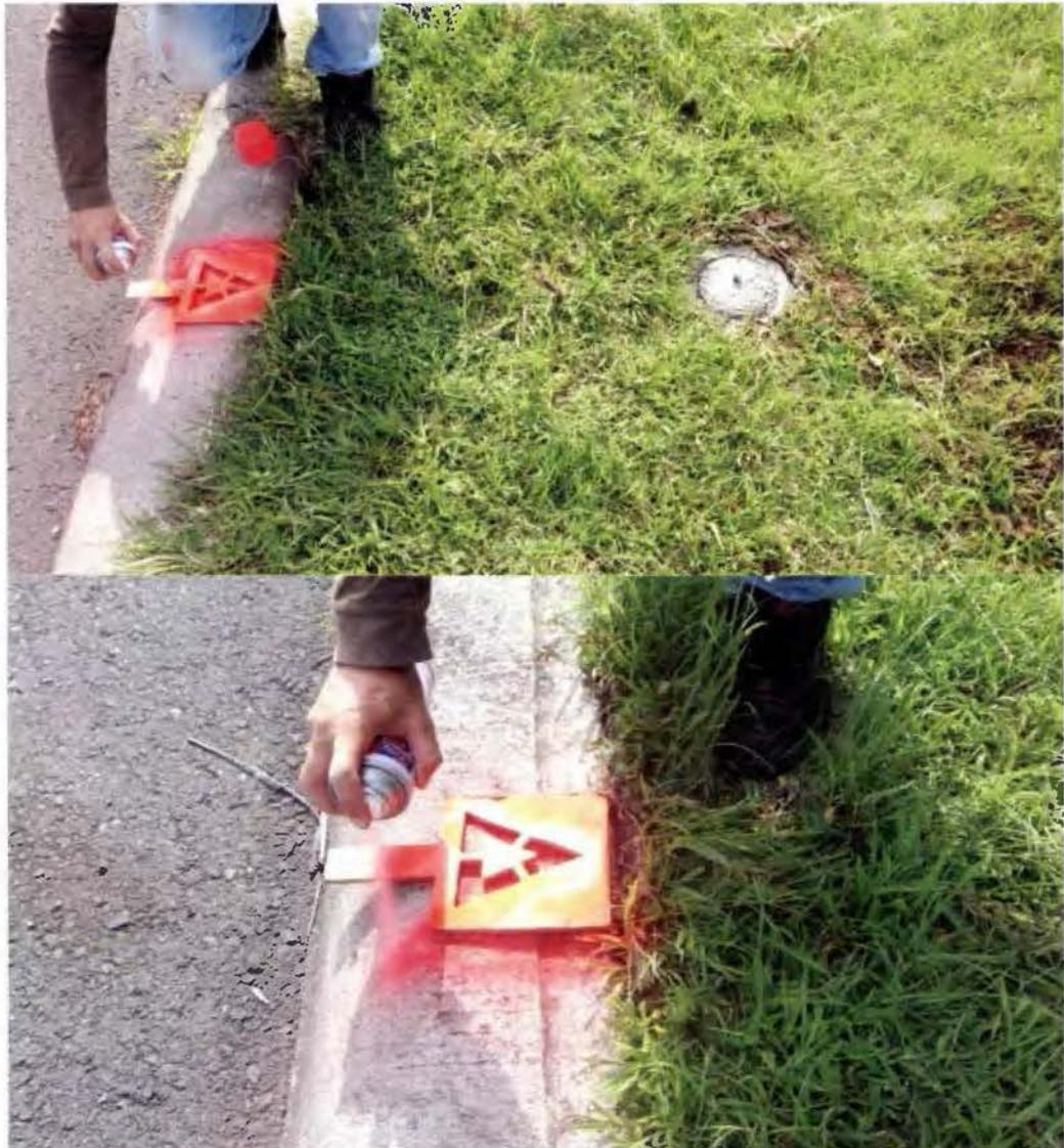
Figura N°26: Demarcación refractiva de cada Hito
