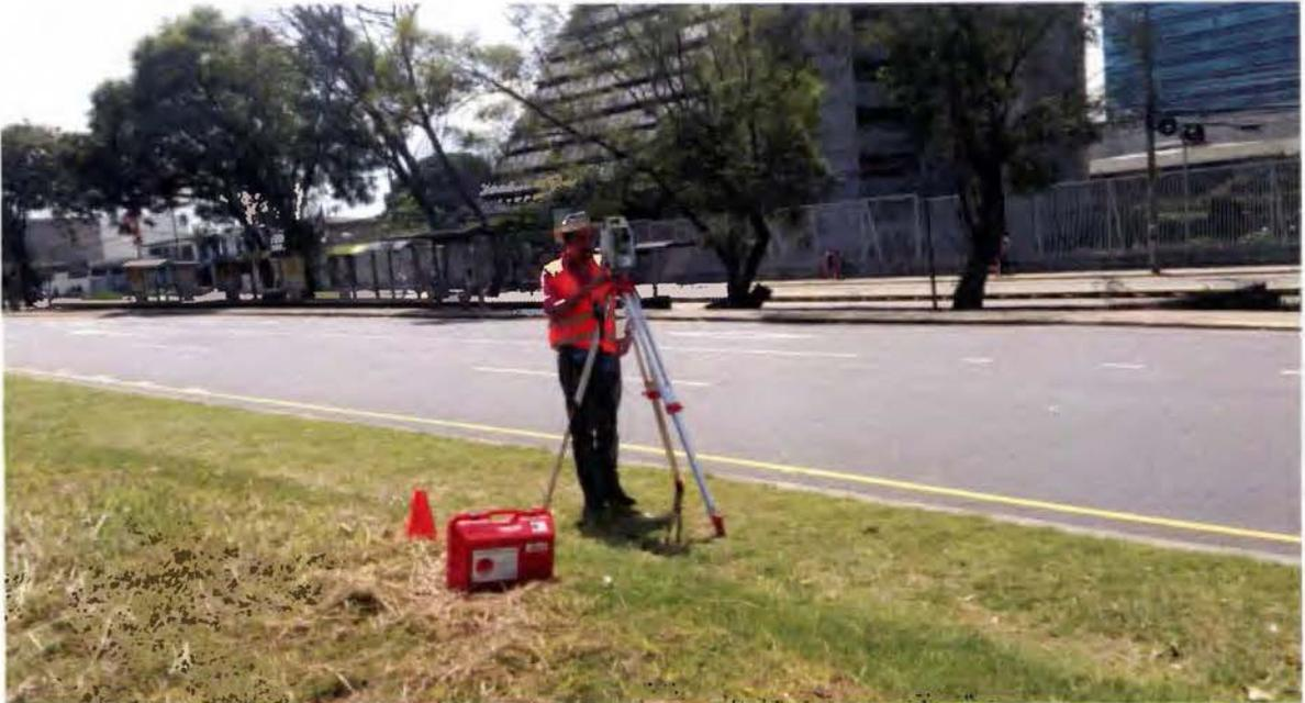
Figura N°45: Medición de distancias horizontales de la Base
