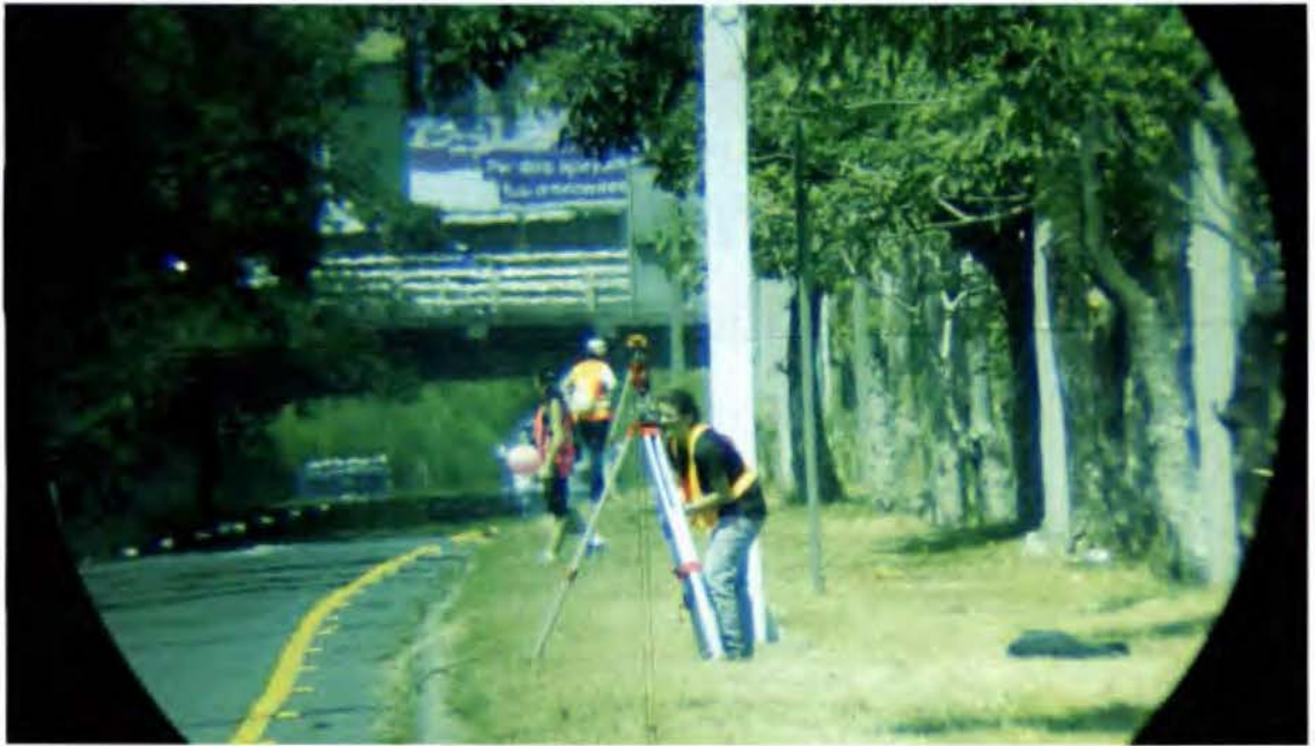
Figura N°47: Estudiantes colocando bases de Prisma en Hitos Fuente: Propia
