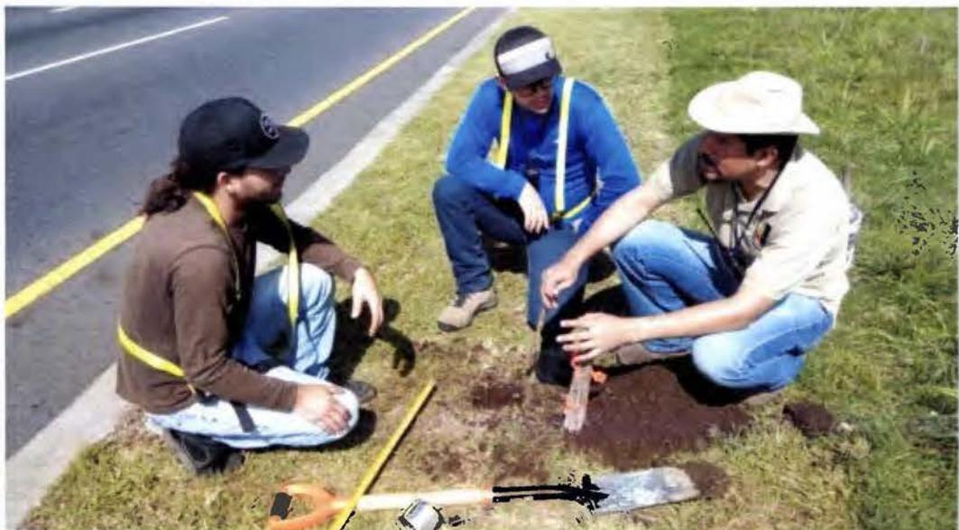
Figura N°18: Excavando para crear Hito N°1
