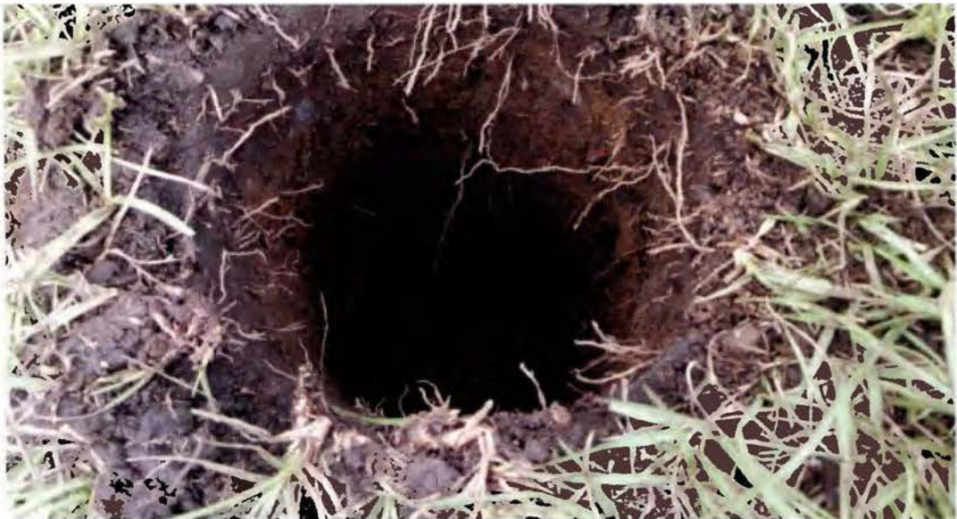
Figura N°19: Excavación terminada Hito N°1 Fuente: Propia
