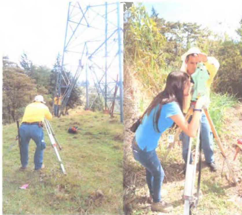
Imagen 13. Levantamiento de campo por parte de la cuadrilla de trabajo (Fuente: Elaboración propia).
