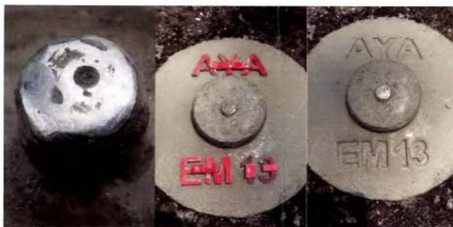
Desgaste de varilla de acero, colocación de centro de punto y grabado sobre el monumento.
