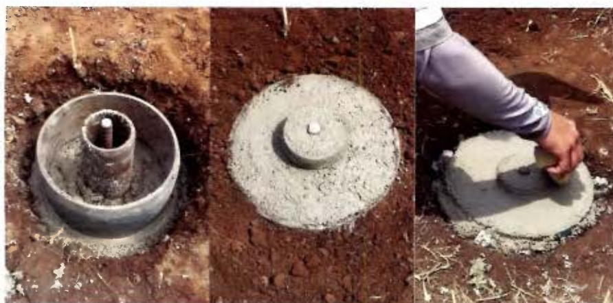
Colocación de anillo de PVC, vertido final de concreto y afinado del monumento.
