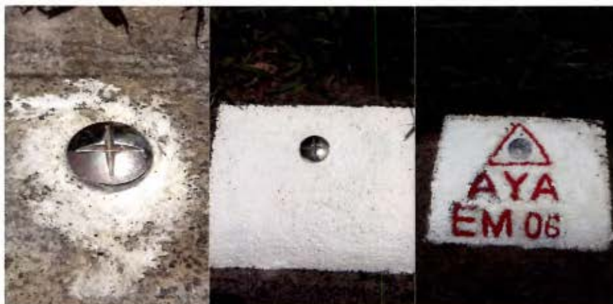
Incrustación de pin, pintura base y nombre del monumento.
