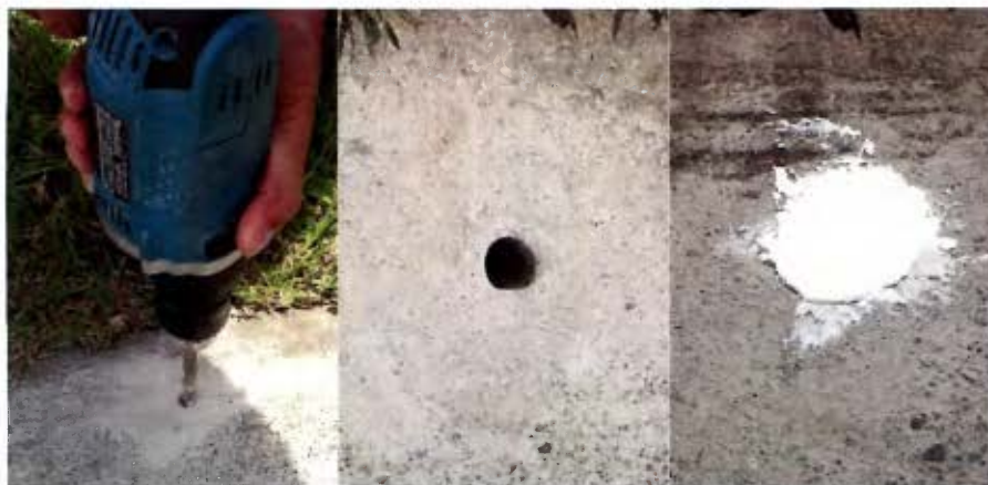
Perforación de superficie, limpieza y llenado con pegamento.
