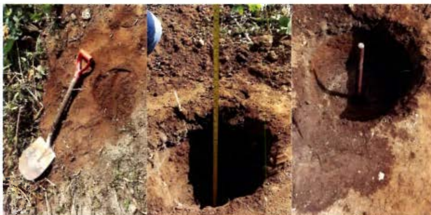
Preparación del terreno, excavación y colocación de varilla principal del monumento.
