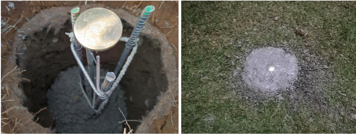
Figura 7. Proceso de amojonamiento con armadura, chapa de bronce, con relleno de concreto, en Quepos. Fuente: Propia, 2021.
