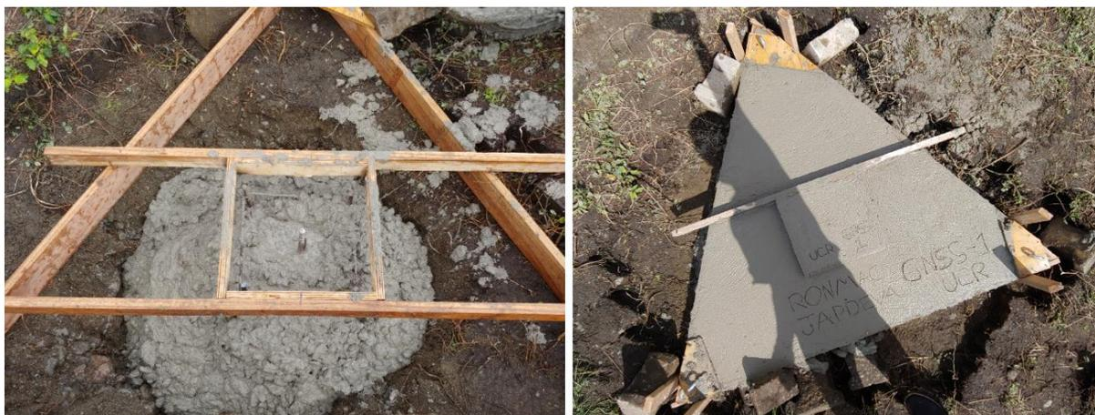
*Figura 8. Colocación del mojón de concreto según las recomendaciones de la UNAVCO en el puerto de JAPDEVA.
