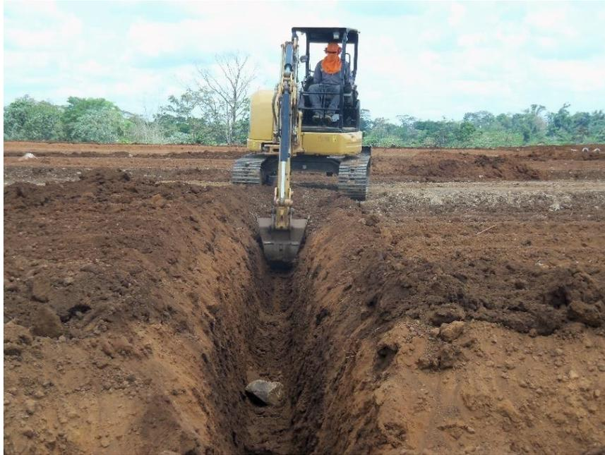
Figura 7.5. Canales para el drenaje del terreno (Fotografía propia)
