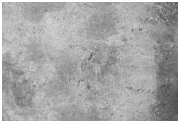
Figura 3.4: Concreto colado en sitio (Elaboración Propia)
