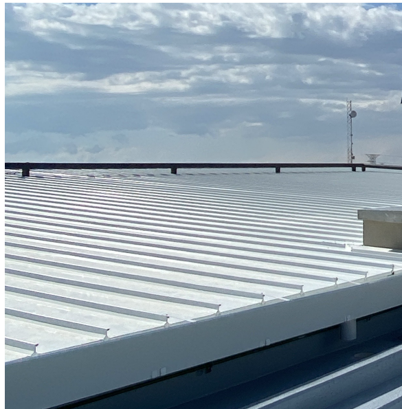
Figura 3.12: Ejemplo de panel tipo “sandwich” (Elaboración propia)
