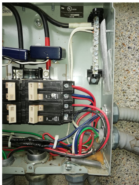
Figura 3.9: Medidores de tensión en centro de carga principal, Autoría proia
