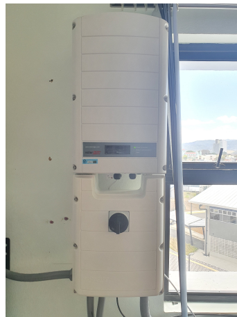
Figura 3.5: Inversor DC/AC Solar Edge SE7600A-US22 , Autoría propia
