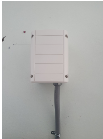
Figura 3.6: Autotransformador Solar Edge SEAUTOTX-5000 , Autoría propia
