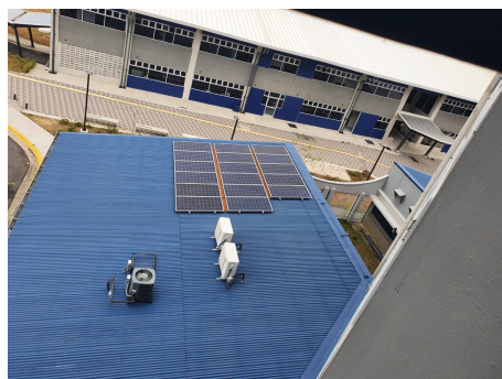
Figura 3.1: Vista área de módulos solares de la EIEUCR, Autoría propia
